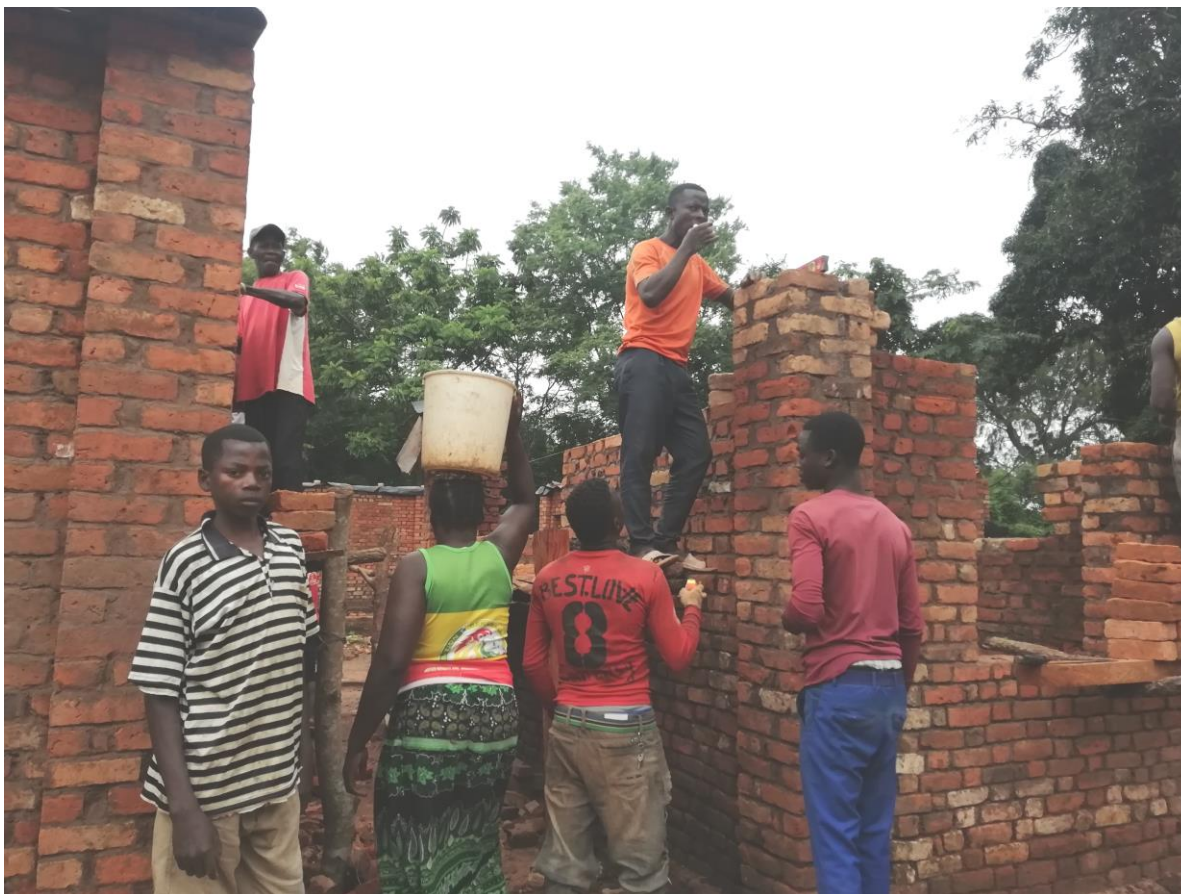
Viele Hände helfen beim Bau der neuen Krankenstation
