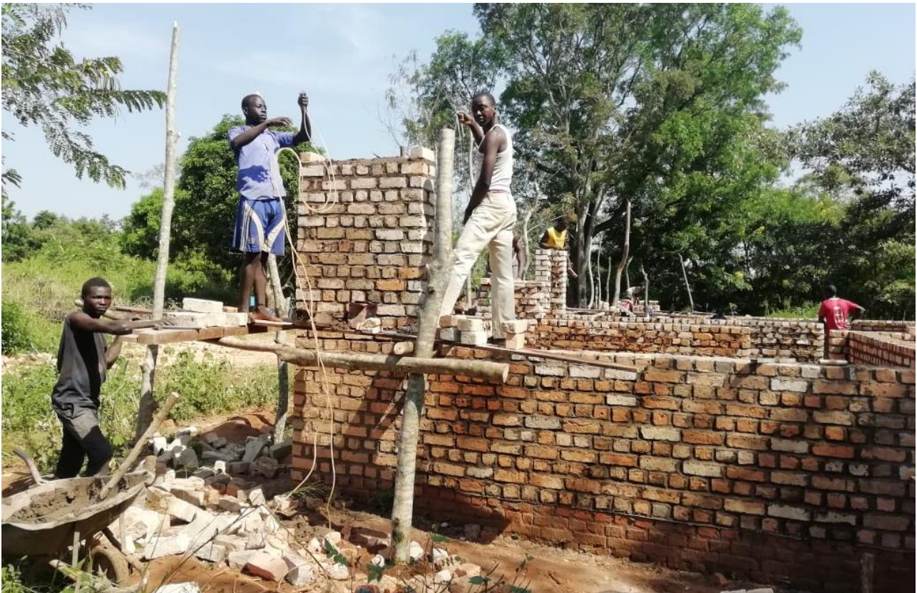
Maurer beim Bau der neuen Krankenstation
