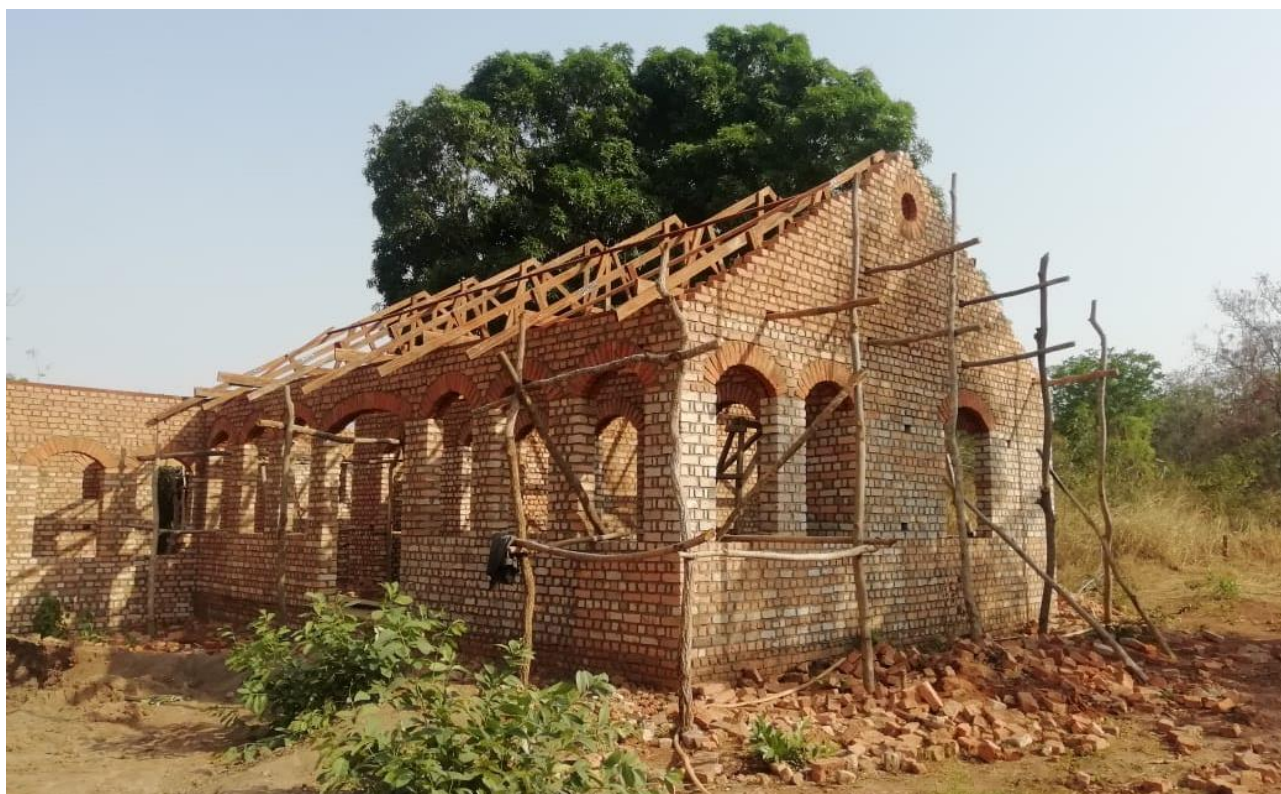
Ein Flügel der neuen Krankenstation bereits mit Dachstuhl
