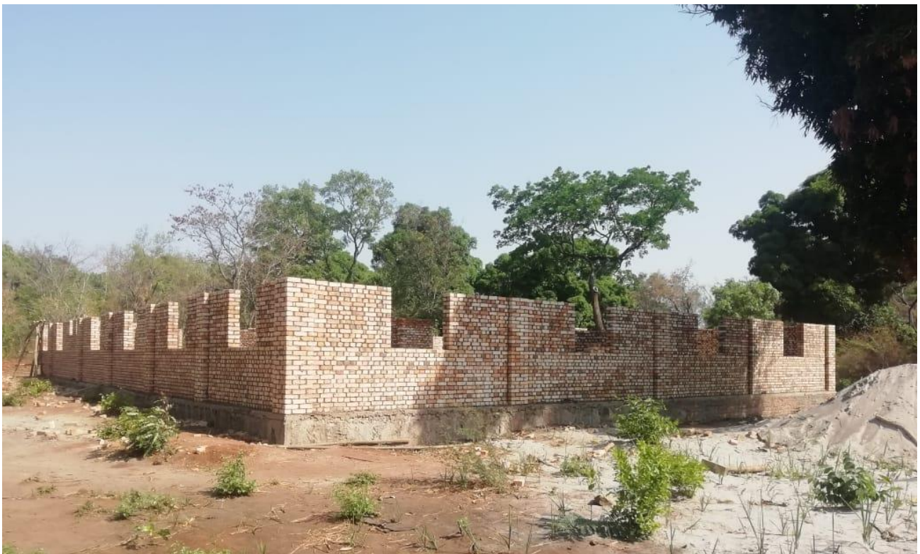
Der Bau des Gymnasiums schreitet voran
