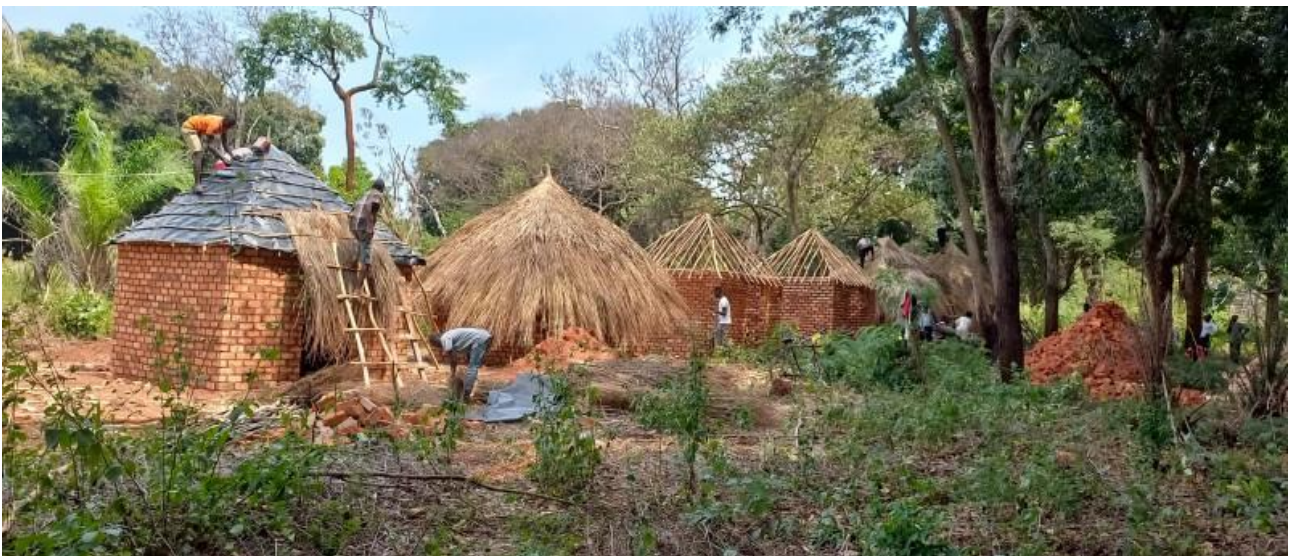
Auf dem Grund der Pfarrei werden Hütten für die Vertriebenen errichtet
