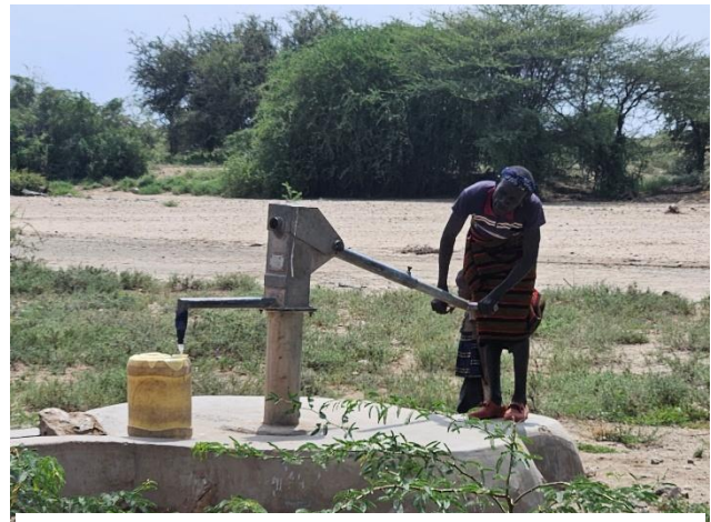
Trinkwasserbrunnen mit Handpumpe
