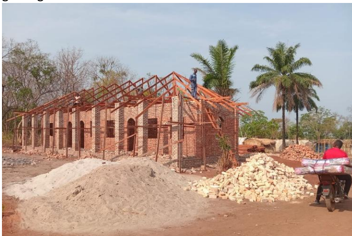
Die neue Grundschule in Ave Maria kurz vor der Fertigstellung
