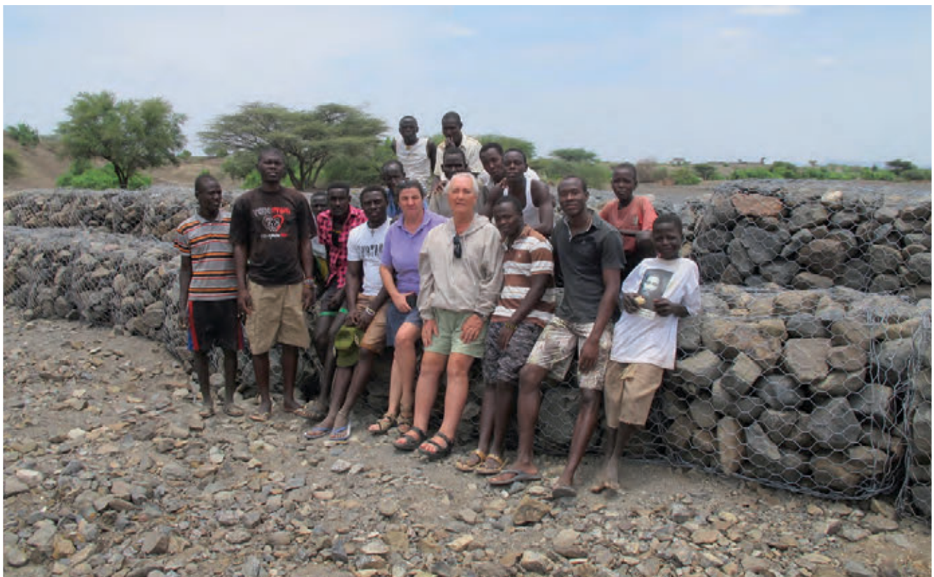
Supervising the construction of gabions at Nariokotome Mission, 2012. Supervisando la construcción de gabiones en la Mision de Nariokotome, 2012.
