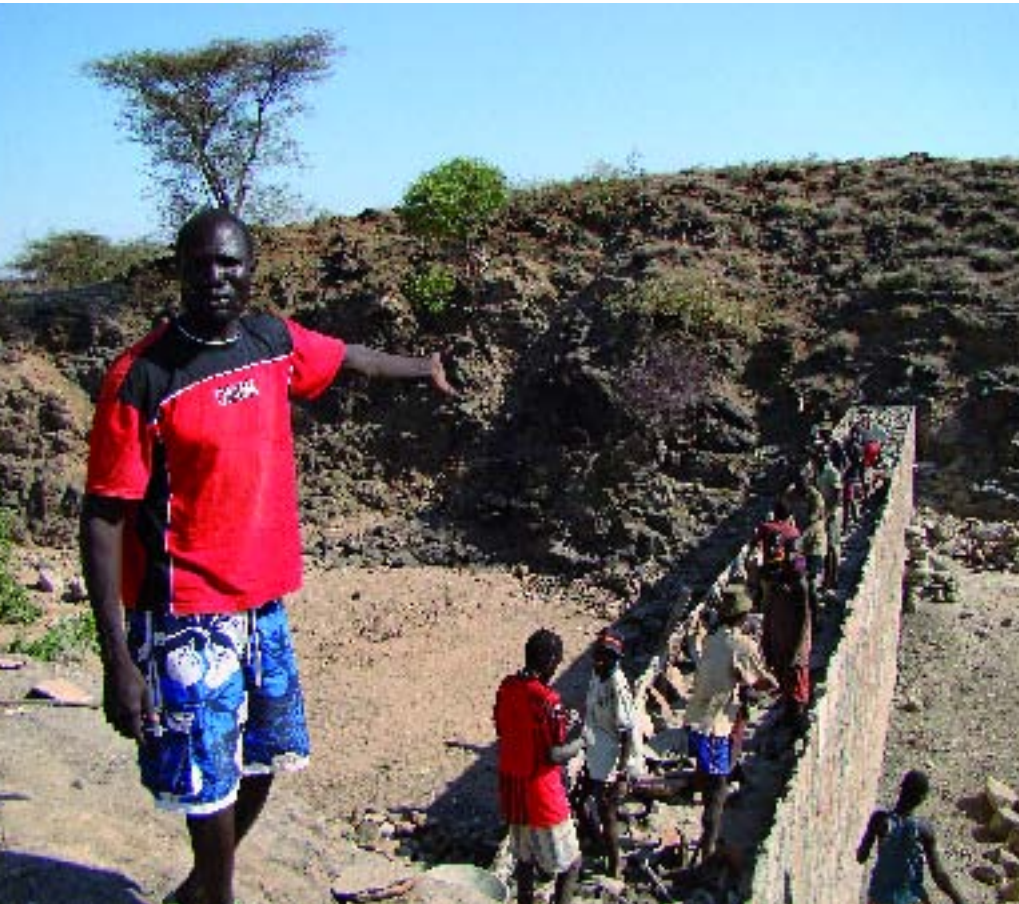
Josephat Akine and his team at work on a rock dam. Josephat Akine y su equipo construyendo una presa de roca.
