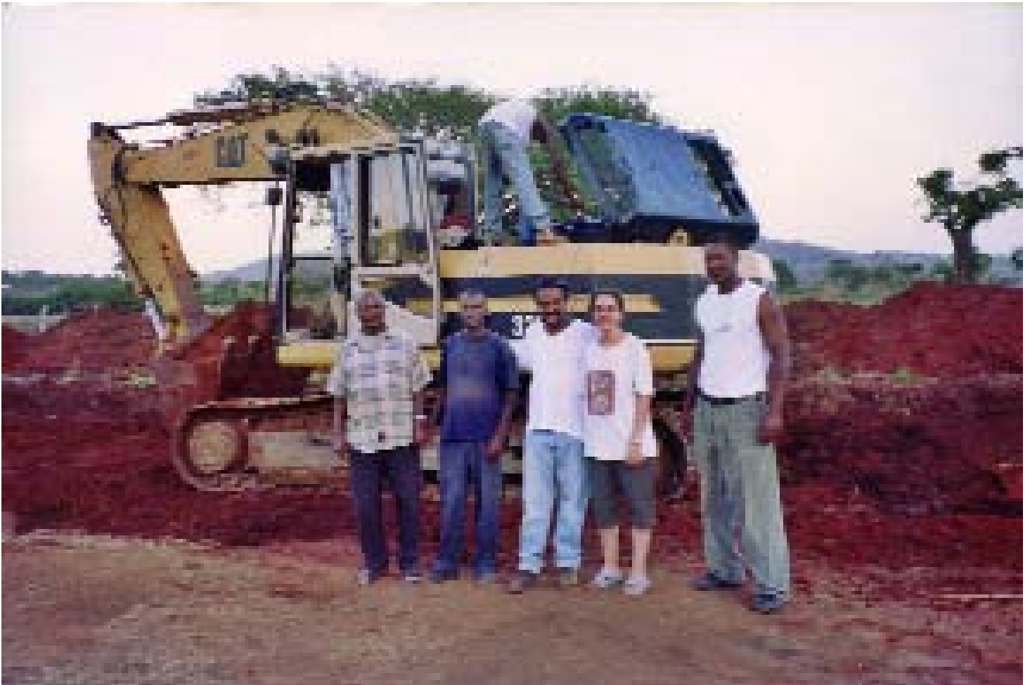
Gideon Alula (center) brought his excavators to the Andode Mission in order to build a dam. Gideon Alula (en el centro de la imagen) trajo sus excavadoras a la misión de Andode para hacer una presa.
