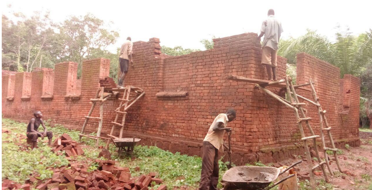
Bau der Schreinerei mit Unterrichtsräumen
